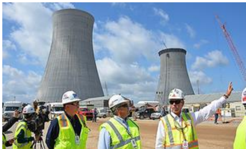
WH社が米国で建設中の Vogtle原発(GA) (2016.6.16朝日Digital Newsより)
