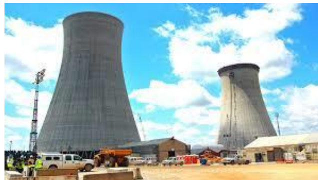
建設中のVogtle原発
