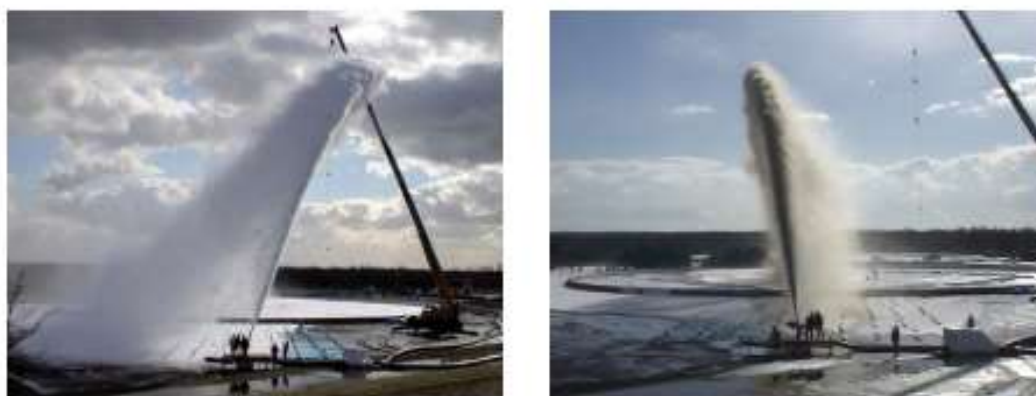
苫小牧石油備蓄基地における泡放射実験
