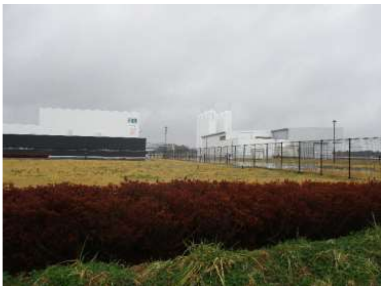
図2. 福島水素エネルギー研究フィールド 3月21日
