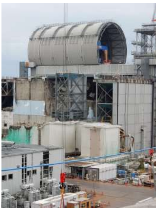
図1. 3号機使用済み核燃料取り出し用ドームの据付状況
