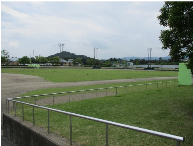
照明塔付き広野町運動場
