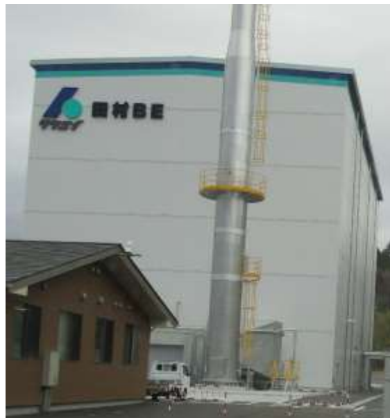
図4. HEPA フィルタと排気筒の正面
