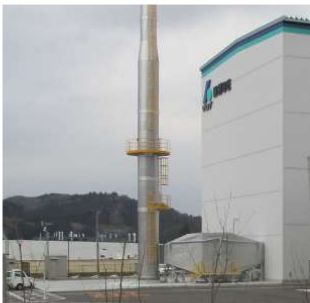
図3. HEPA フィルタと排気筒の側面
